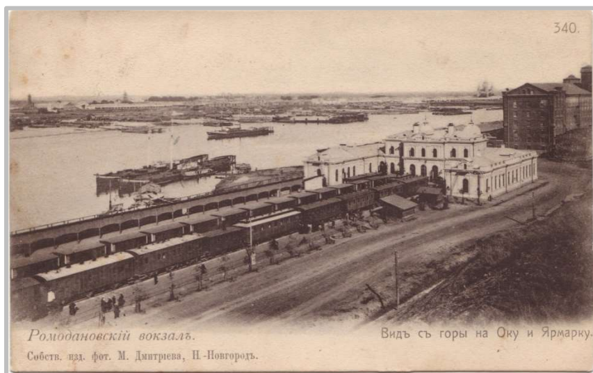
תחנת הרכבת בגורקי
